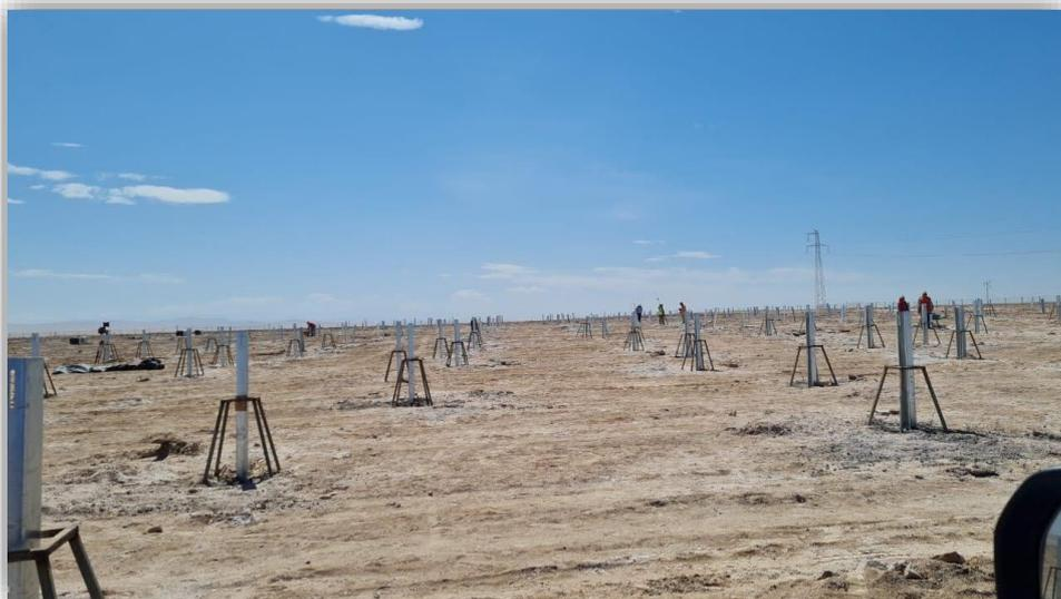
*Micropilotes para hincado Planta Fotovoltaica Copihue – Solarpack Chile S.A.*
